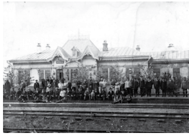
Деревянный вокзал железнодорожной станции Болотная, конец XIX века
